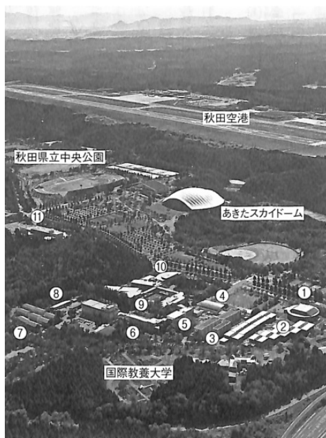
国際教養大学は、秋田空港からほど近い森のなかにある ①多目的ホール②グローバル・ヴィレッジ(学生宿舎)③こまち寮(学生寮)④カフェテリア⑤⑥⑨講義棟⑦ユニバーシティ・ヴィレッジ(学生宿舎)⑧サークル棟⑩図書館⑪プラザクリプトン(ゲストハウス)
